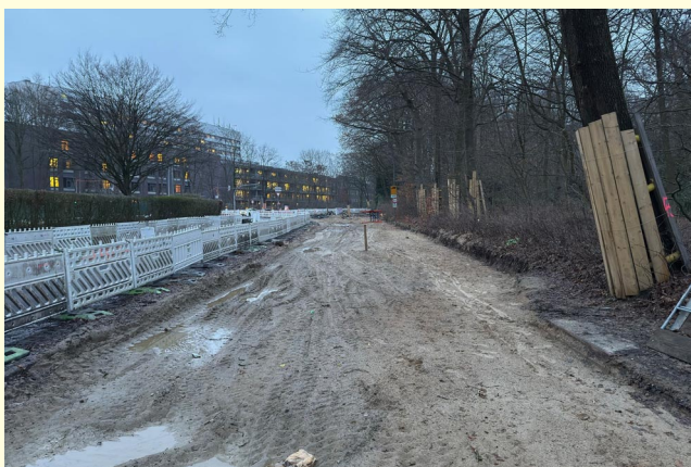
Umfangreiche Arbeiten: Rechte Fahrspur der Jüthornstraße bis an den Rand des Gehölzes freigelegt
