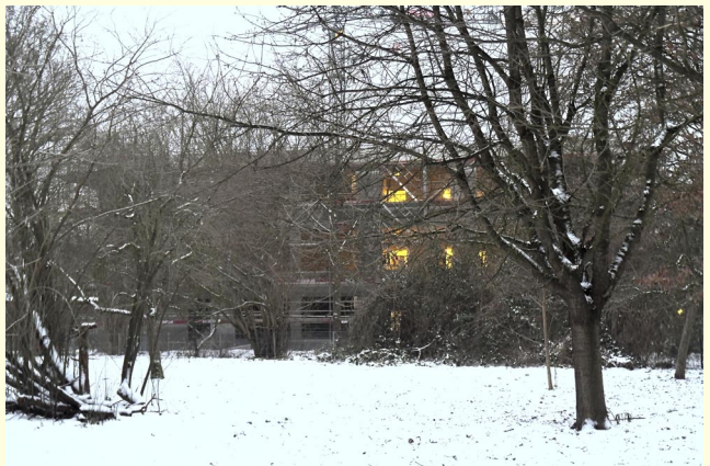
Neues Schulgebäude: Der Rohbau des dreistöckigen Neubaus der Stadtteilschule Marienthal steht
