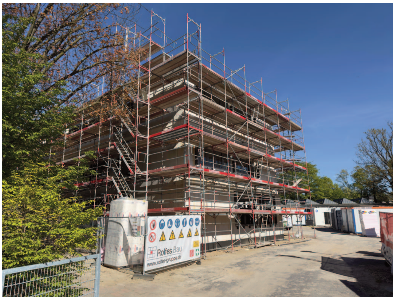
Status quo des Neubaus des Schulgebäudes
