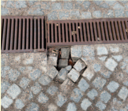
Eingebrochene Pflastersteine, ... ... provisorisch „beheben“ und ... ... endgültig repariert
