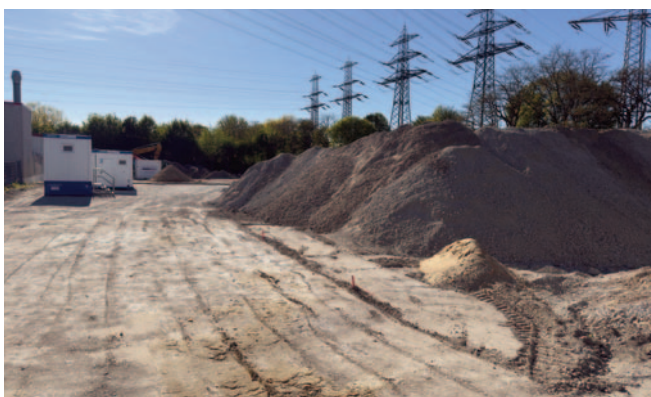
Noch kein Fundament gegossen, ...
