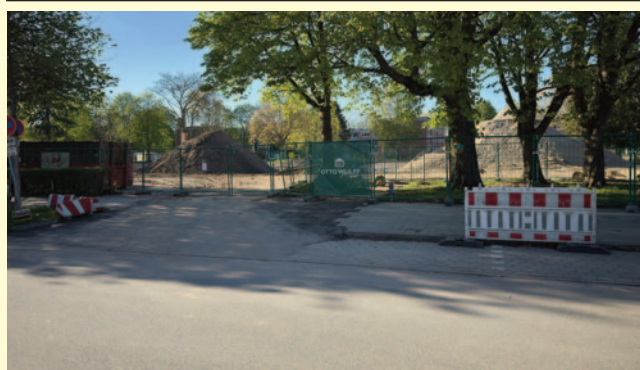
Einige Häuser mussten rückgebaut werden
