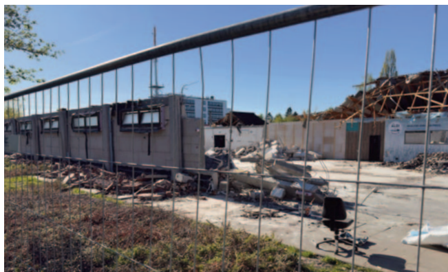
... noch etwas Mauerwerk – Stand Ende April 2026
