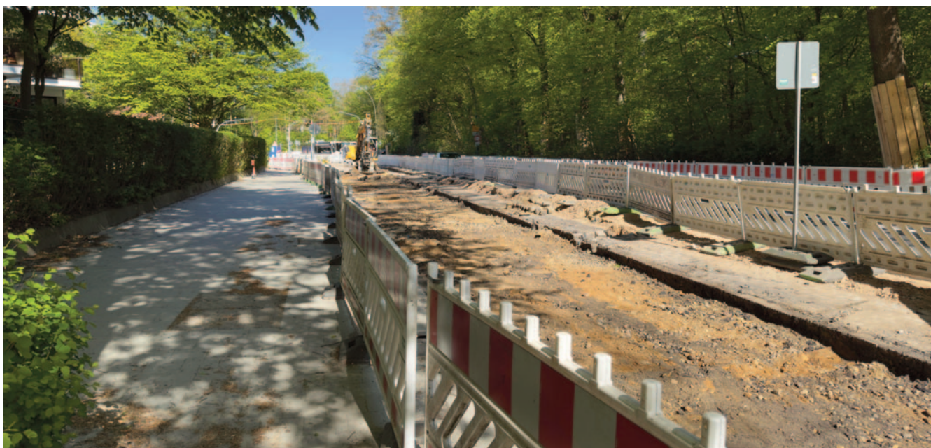
Die derzeitigen ersten Baumaßnahmen in der Jüthornstraße
