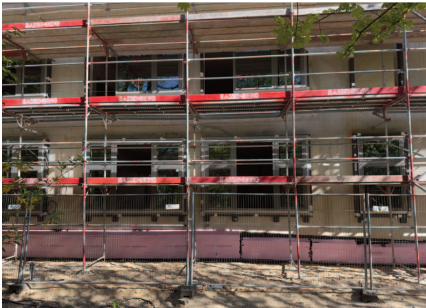
Nun auch mit eingebauten Fensterrahmen und Fenstern
