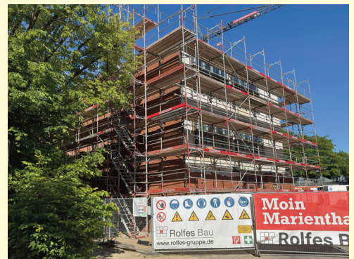
Typisch norddeutsche Klinkerfassade
