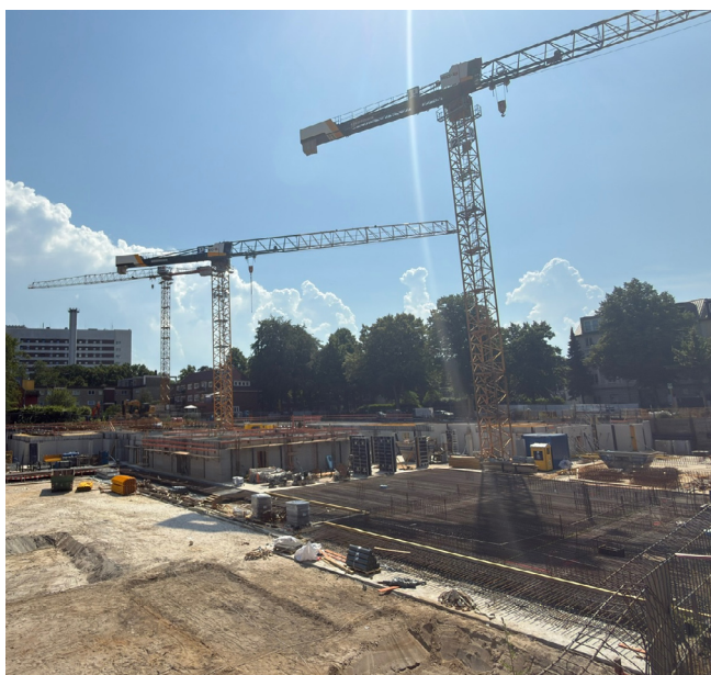
Fertigteile ermöglichen zügiges Bauen
