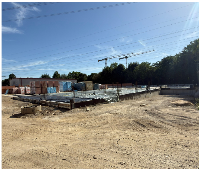
Der weitere Bau wird vorbereitet
