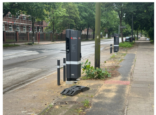
Zwei neue Elektro-Lade-Säulen
