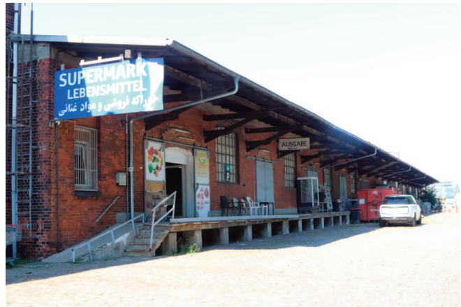
... und die Lagerhalle mit Rampen
