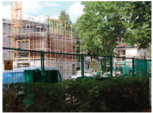
Zwei Mehrfamilienhäuser im Bau
