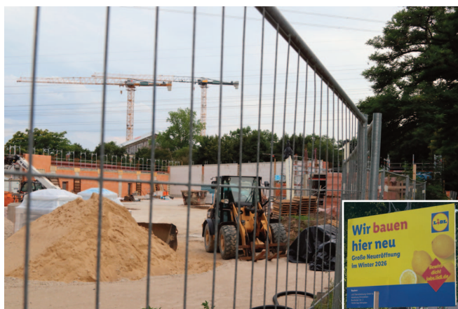
Auch ein Gerüst wurde schon aufgebaut
