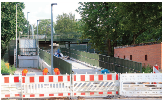
Der Zugang zur neuen Brücke auf Marienthaler Seite
