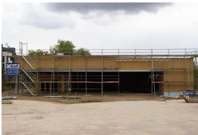
Noch kein Dach und keine Fassadenfront
