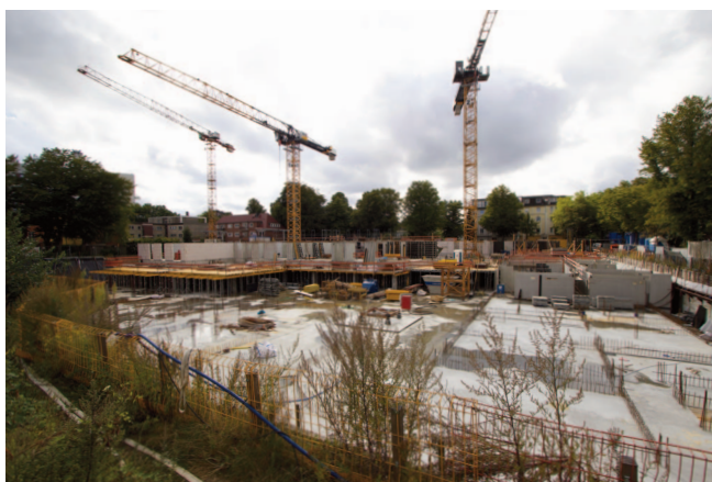
Ein weiterer Kran kommt hinzu
